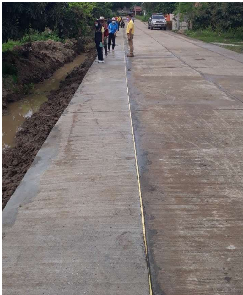
พนังคอนกรีตเสริมเหล็กป้องกันน้ำเซาะถนน หมู่ที่ ๔
