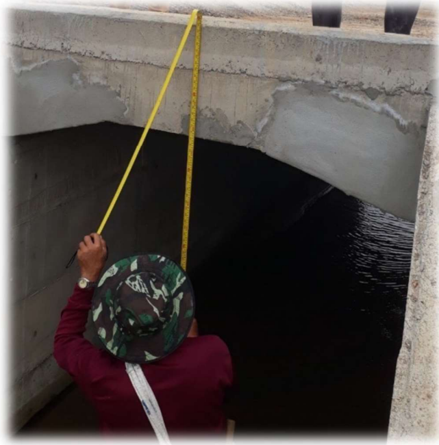
ท่อเหลี่ยมคอนกรีตเสริมเหล็ก หมู่ที่ ๖
