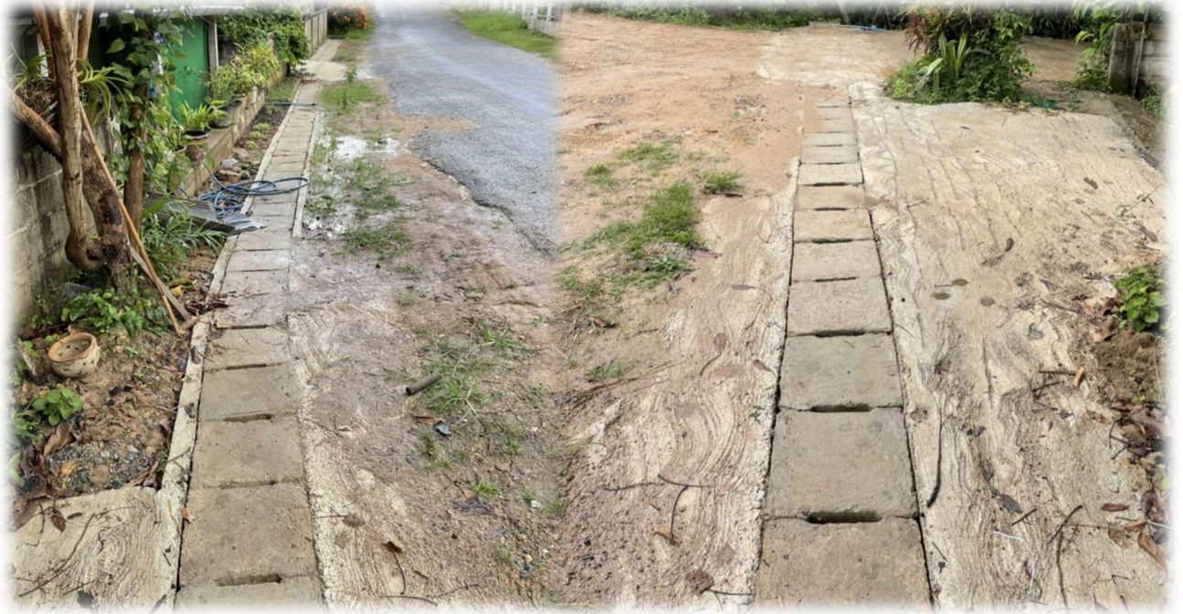
วางระบายน้ำคอนกรีตเสริมเหล็ก รูปตัวยู ชนิดมีฝาปิด บ้านชมภูใต้ หมู่ที่ ๑๘
