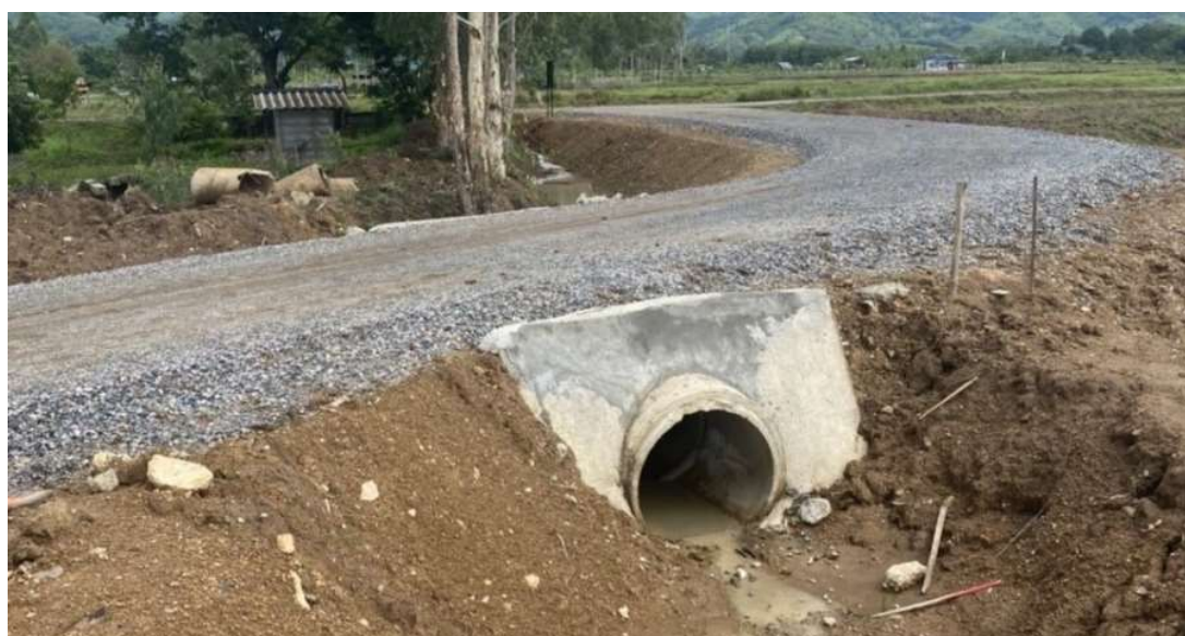
ถนนผิวทางหินคลุก สายห้วยหมาโน - หนองยางหอม หมู่ที่ ๘
