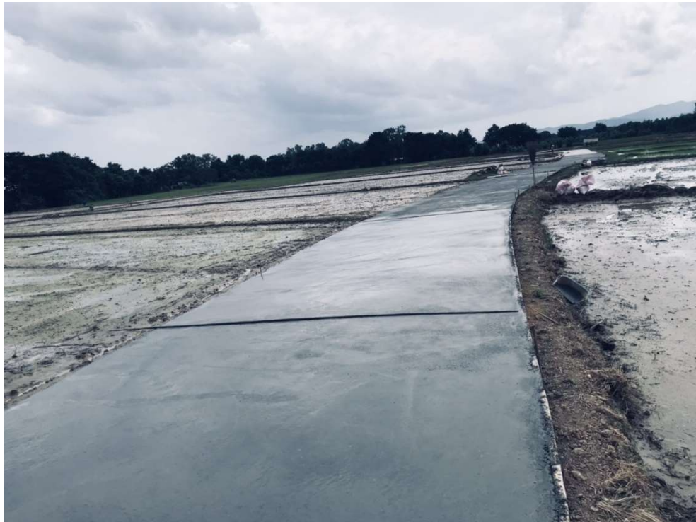
ถนนผิวทางหินคลุก หมู่ที่ ๒ สายบ้านห้วยหลวงใต้ - สายลอมเกล้าออก
